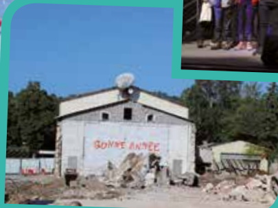
Lancement des travaux du cinéma
